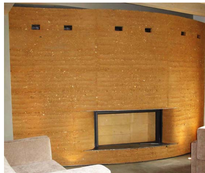
Cheminée préfabriquées en pisé pour un chalet de Mégève, en haute-Savoie, réalisation Caracol/Akterre.
