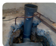
Mise en place du puisard
