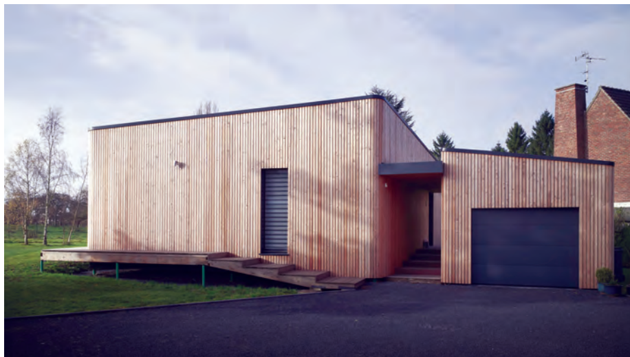
Photo 8.6 Entrée de la maison au nord Crédit photo : J. Lanoo
