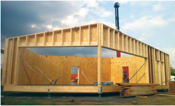
Photo 8.7 Pose de l'ossature bois Crédit photo : A. Moreel
