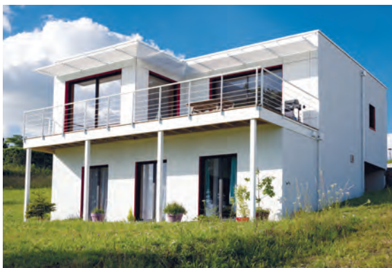
Photo 8.2 Les pièces de vie donnent sur une terrasse en R+1 orientée au sud et bénéficiant de la vue
