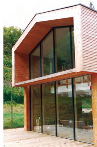
Photo 8.13 Le pignon sud totalement vitré (mur-rideau Stabalux)
