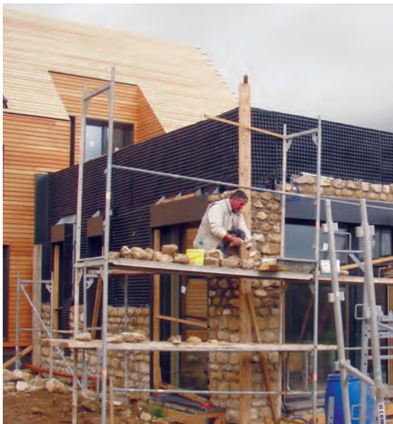
Photo 8.20 Mise en œuvre de la pierre du Vexin
