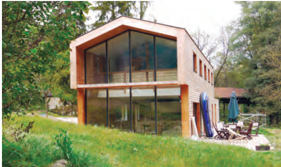
Photo 8.14 La dalle bois du rez-de-chaussée s'étend au sud et à l'ouest pour dégager une large terrasse extérieure
