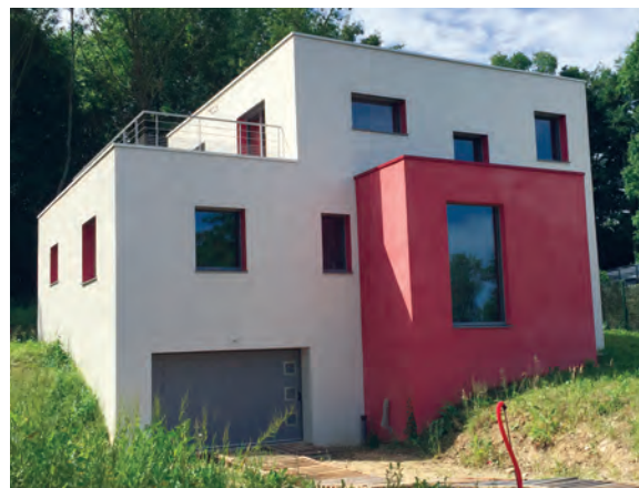
Photo 8.9 Une maison pour laquelle les contraintes (masques solaires et PLU) ont conduit au renforcement de l'isolation de l'enveloppe
