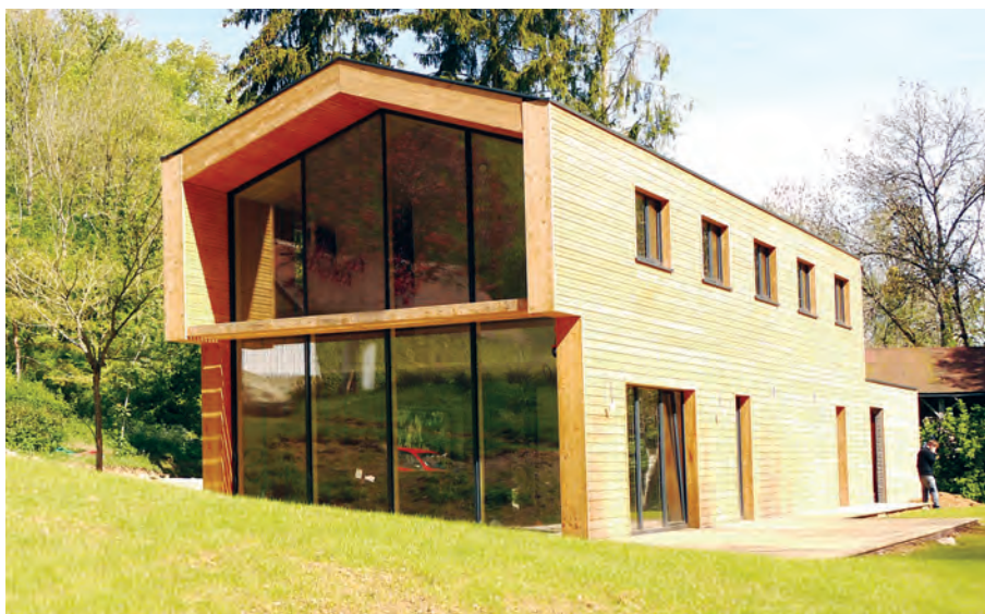
Photo 8.11 Une maison non labellisée, en zone inondable et dans un secteur très contraint par l'ABF, qui développe sa façade principale à l'ouest
