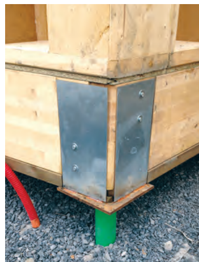
Photo 8.5 Maison sur pieux métalliques
