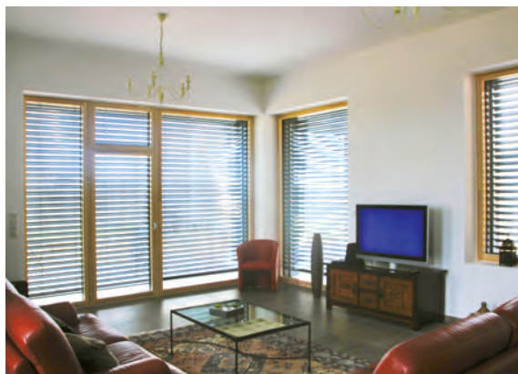
Photo 8.23 De grandes baies vitrées en triple vitrage équipées de BSO automatisés pour le confort d'été
