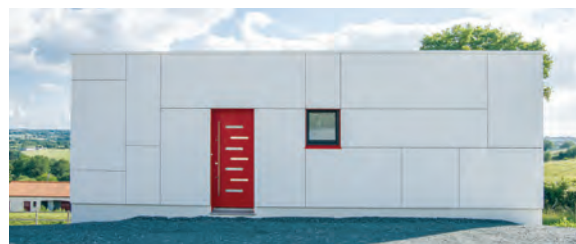
Photo 8.3 Entrée de la maison au nord, au premier étage
